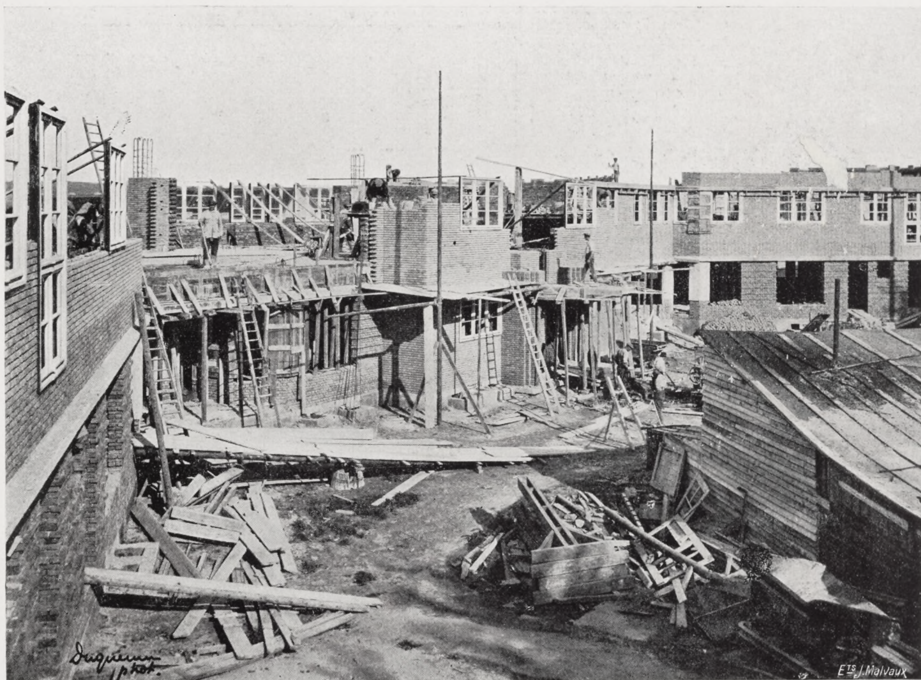
VUE DU CHANTIER LORS DE LA CONSTRUCTION DU PREMIER ÉTAGE DE L'IMMEUBLE
